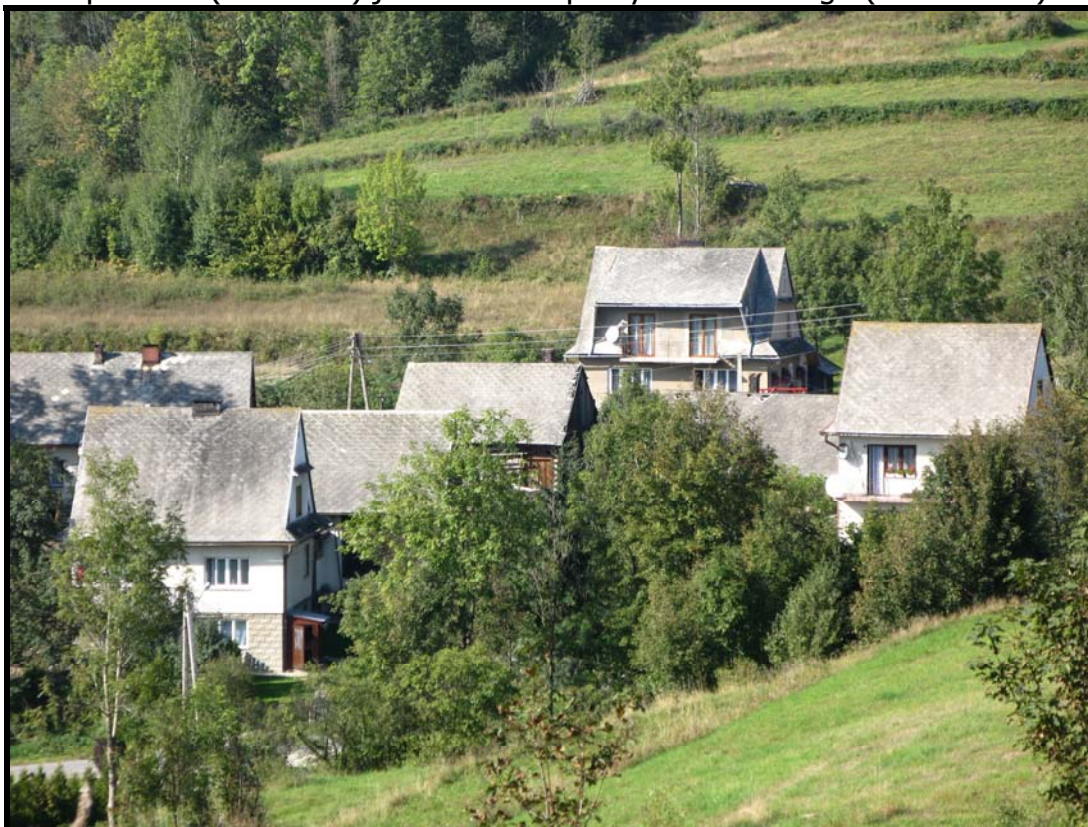
Rys. 8. Zdjęcie obrazujące wykorzystywanie wyrobów azbestowo-cementowych płaskich (tzw. karo) jako element pokrycia dachowego (tzw. eternit).
