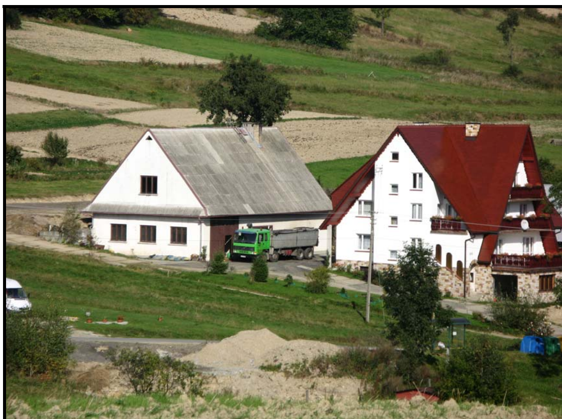
Rys. 9. Zdjęcie obrazujące wykorzystywanie wyrobów azbestowo-cementowych falistych jako pokrycie dachowe (tzw. eternit).
